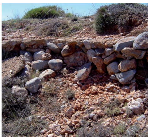
Detalle tejado puesto de mando.
