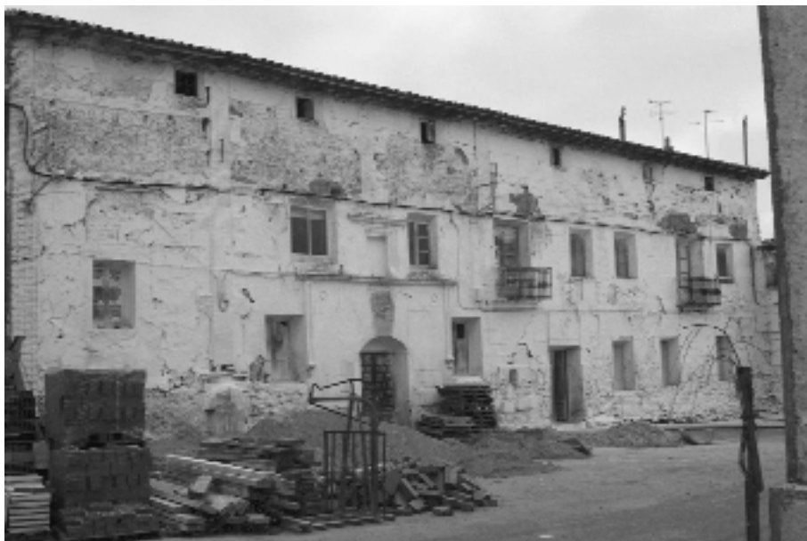
Antigua Casa Grande, fue derribada en 1989. Perteneció a la baronía de los Escriche y fue construida por los Catalán de Ocón (s. XVI).
