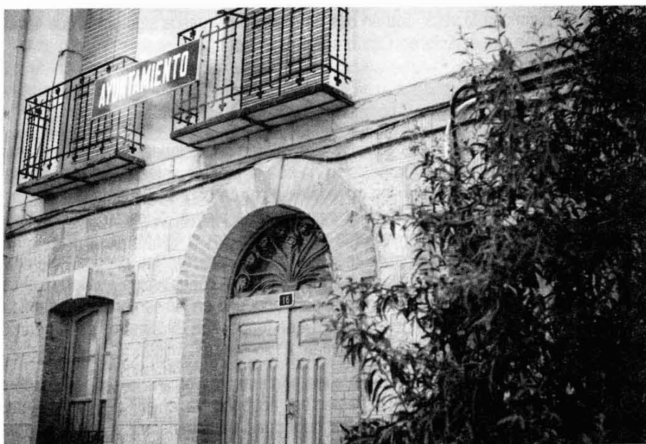
Detalle de construcción. Primera planta de piedra de sillería y ladrillo, el resto de muros y fachada en mampostería al uso.
