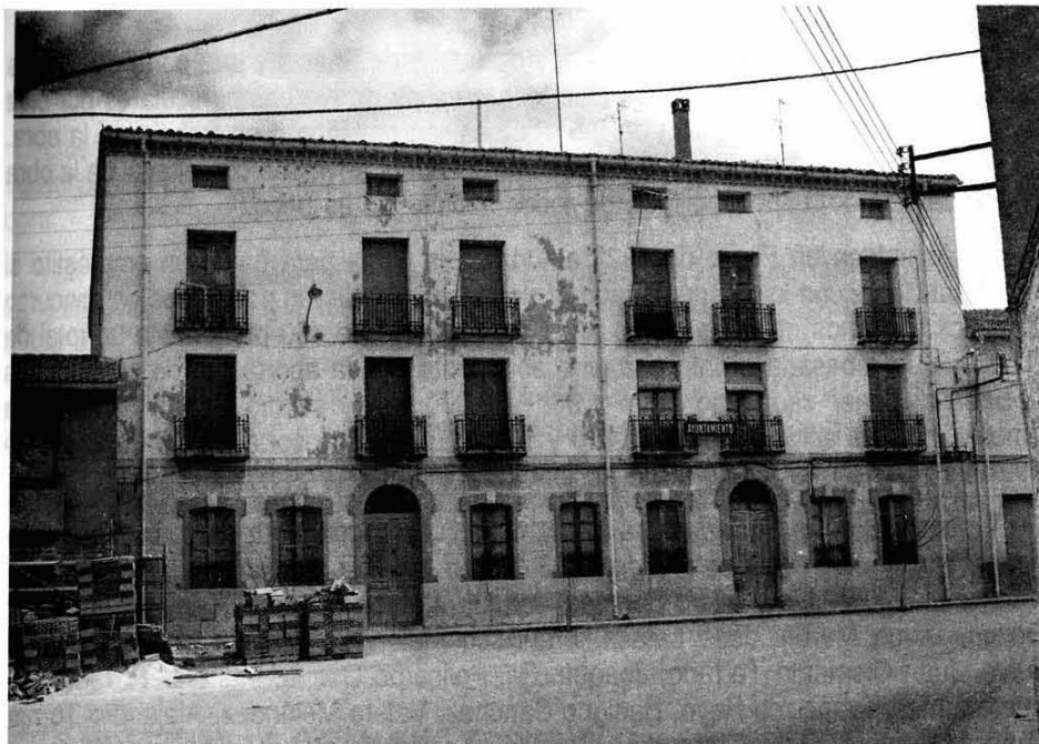
Edificio con la fachada a espaciosa calle; la chapuza no tenía lugar, ni el lujo para ostentación. En la fachada interior hay unas galerías corridas en todos sus ocho pisos
