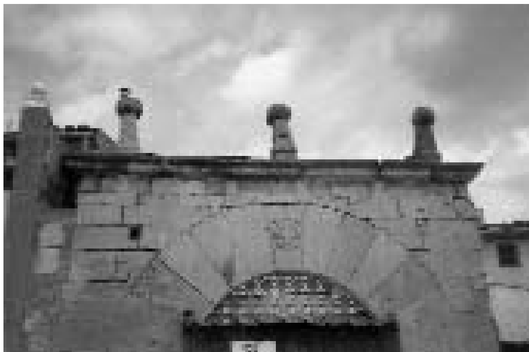
Arco de la portada del antiguo Hospital o Convento.
