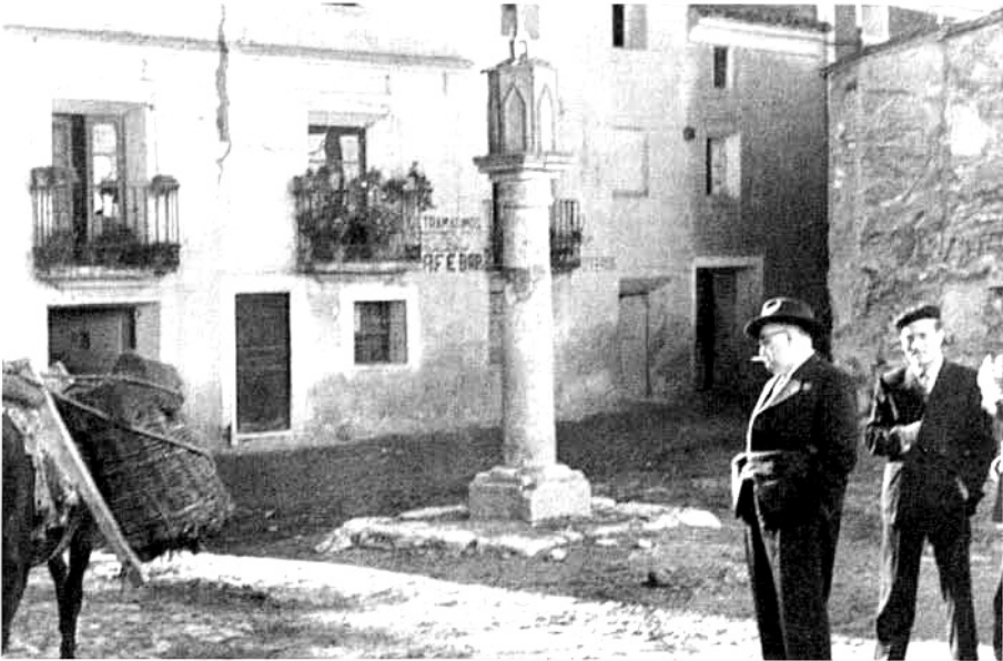
«Plaza del Pilar, con el antiguo pairón».
